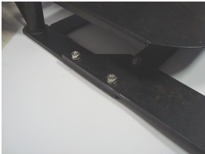
Figura 18: Encaixe dos parafusos entre a base do carrinho e o apoio para os pés.
